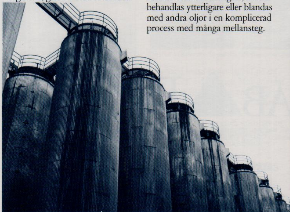
54 olika tankar har automatisk nivå- och temperaturmätning.
